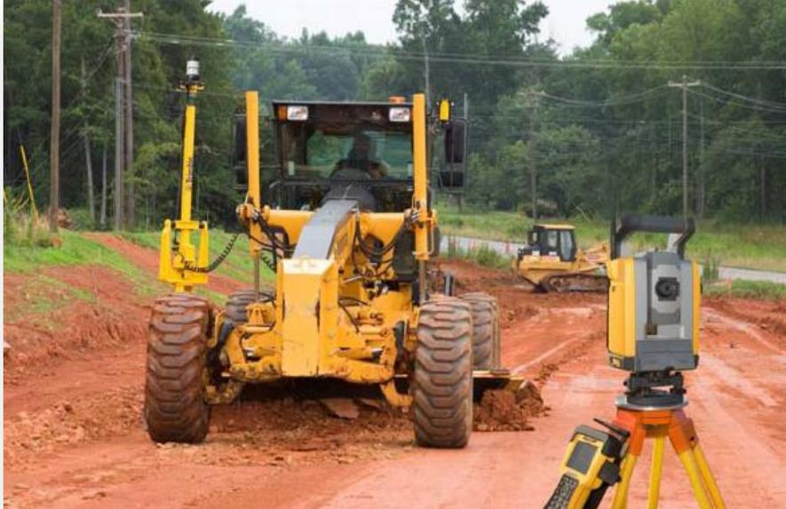
Fig. 13 Motoniveladora trabajando con sistema 3D[14]
