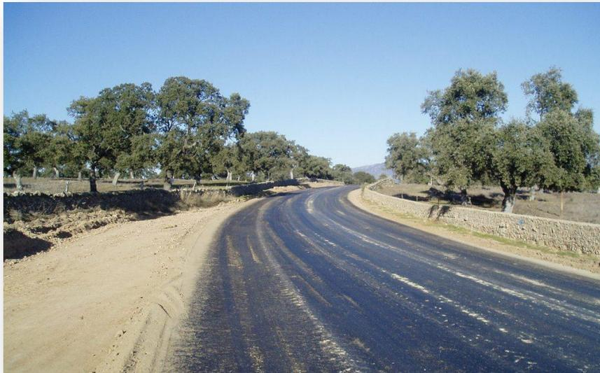
**Fig. 26 Dificultades para nivelar con sistemas automáticos en una obra con frecuentes curvas, cambios de rasante y arboleda**
