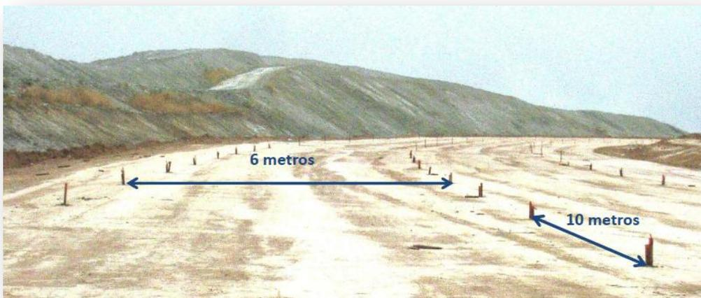
Fig. 2 Disposición típica de las estacas de nivelación en capas de firme
