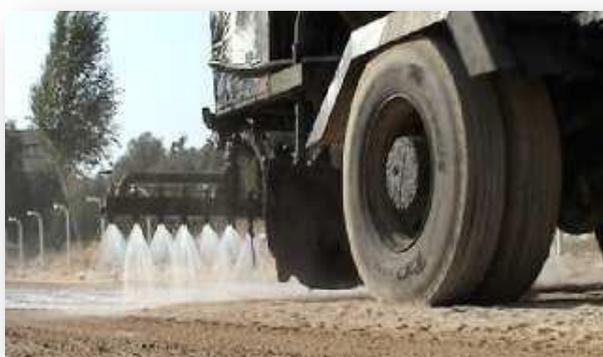
Fig. 18 Extendido de un conglomerante antipolvo
