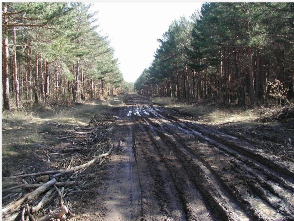
Fig. 8 Camino forestal casi intransitable formado a partir sólo del suelo de la zona
