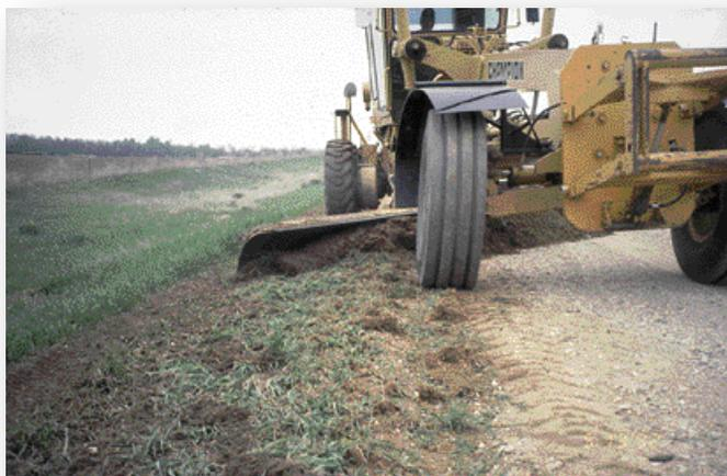
Fig. 3 Reparación tradicional de limpieza de bordes y cunetas
