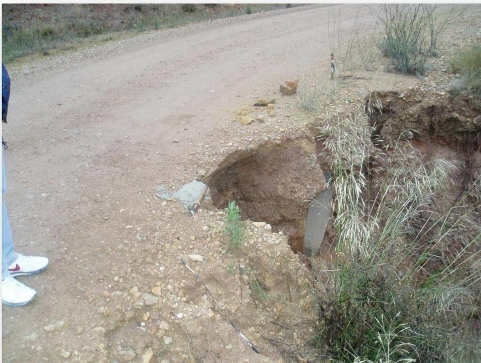
Fig. 23 Pese al mal funcionamiento del drenaje transversal, el suelo estabilizado impide que esta cárcava corte completamente el paso del camino
