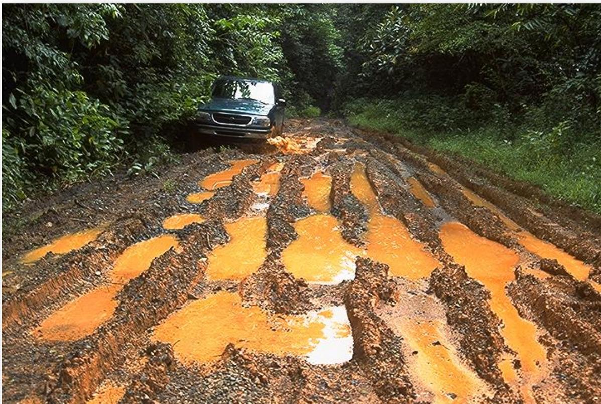
Fig. 13 Evitar en lo posible hacer las reparaciones de escarificado o aportación de material en época de lluvia
