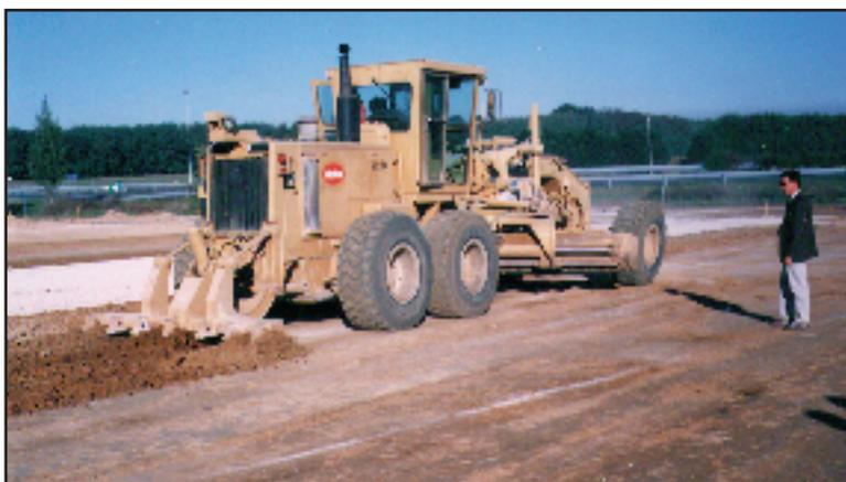
Fig. 10. Escarificación del suelo
