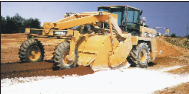
Fig. 9 - Mezclado del suelo y la cal.
