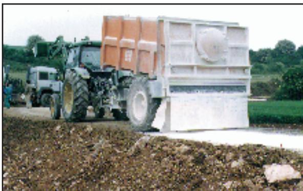
Fig. 12. Extendido de la cal.
