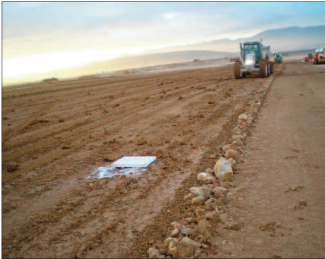
Figura 7.2 Bandeja para control de la dotación de conglomerante y pesado de la misma
