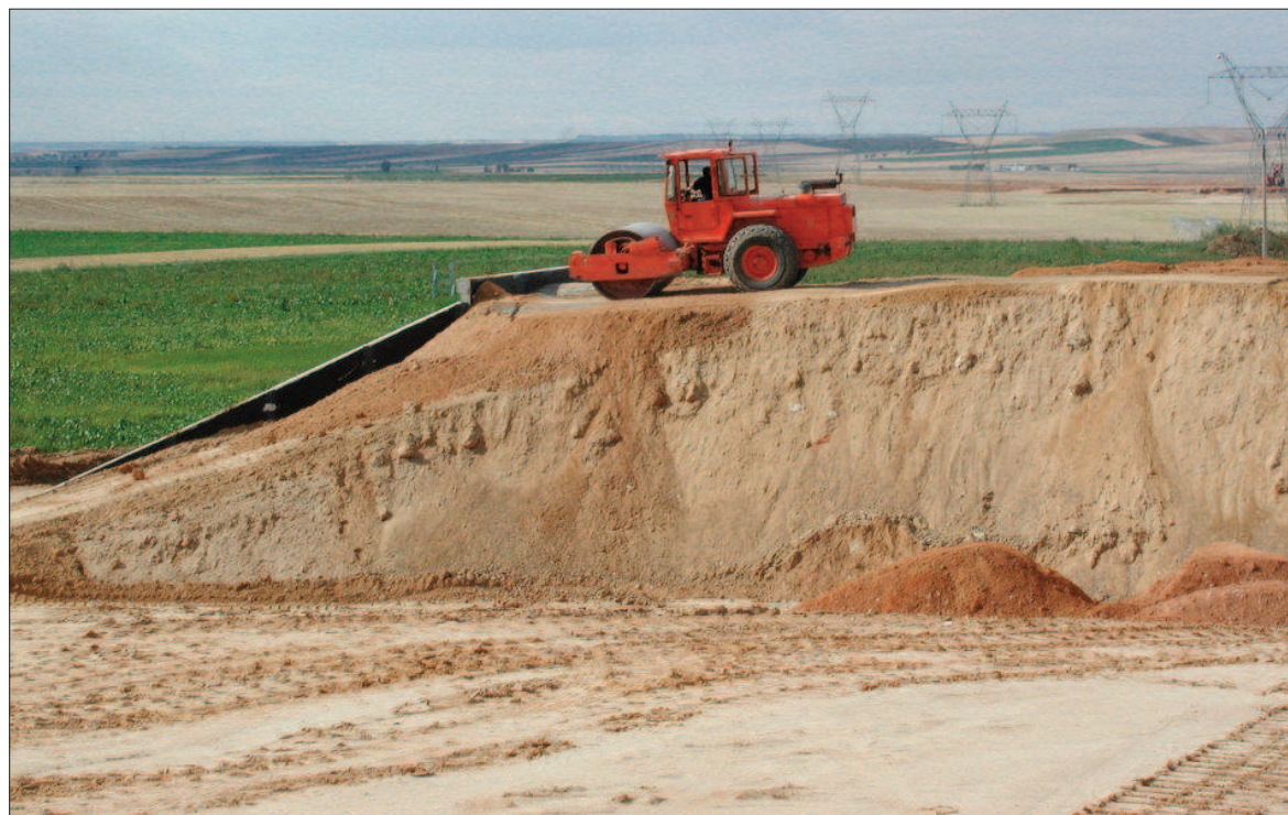
Figura 6.7 Compactación de terraplén
