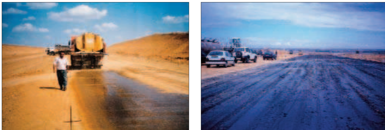
Figura 6.17 Curado de la capa estabilizada con agua y con riego de emulsión
