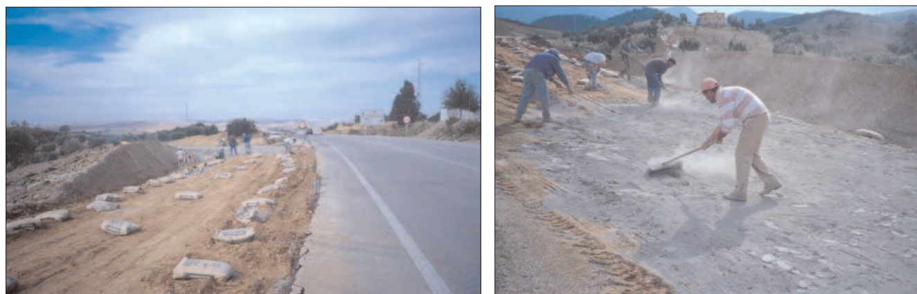
Figura 6.9 Distribución del conglomerante de forma manual en una superficie reducida
