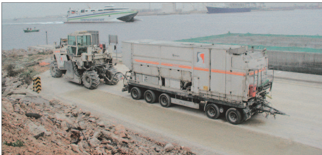
Figura 6.4 Estabilización de una plataforma portuaria
