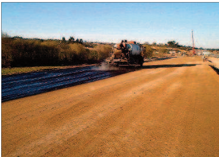
Figura 5.35 Riego de curado con emulsión
