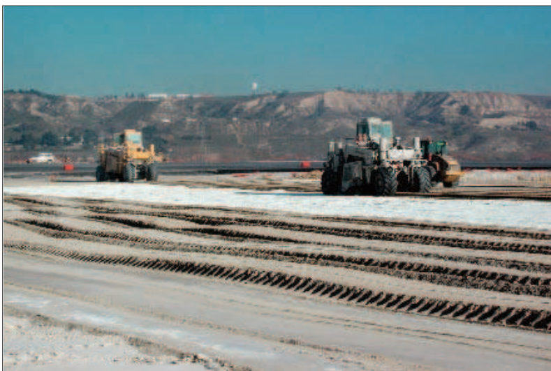
Figura 1.1 Estabilización con cal
