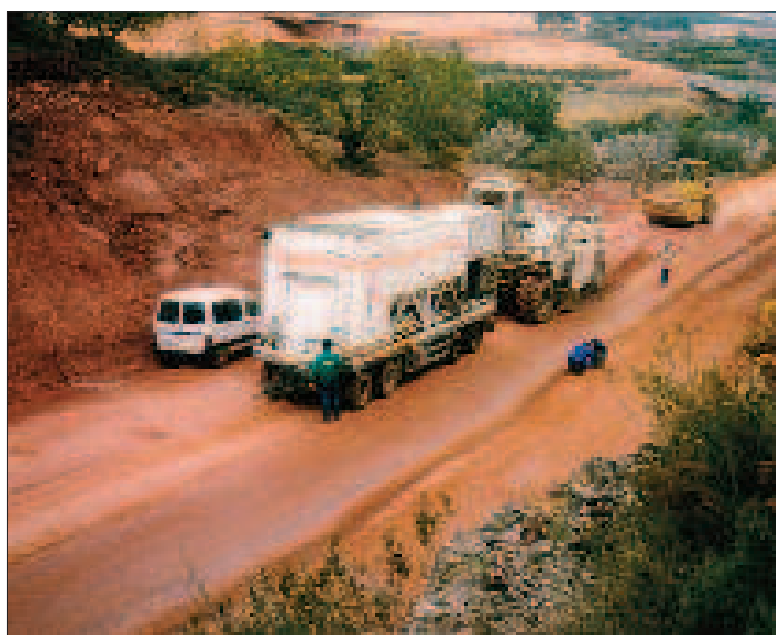
Figura 6.1 Estabilización por vía húmeda
