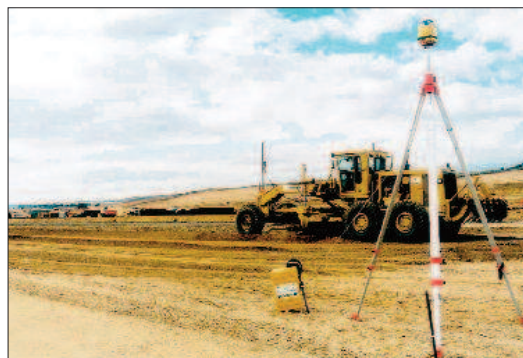
Figura 5.34 Equipo de nivelación láser
