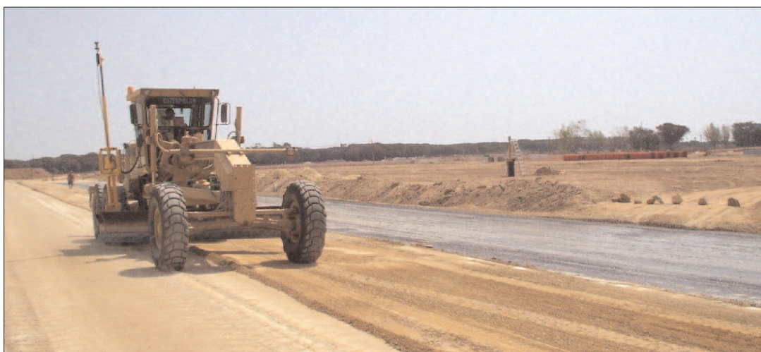
Figura 5.33 Motoniveladora guiada por sistema 3D
