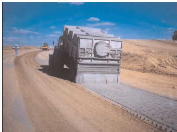
Figura 6.10 Distribución del conglomerante en polvo (vía seca)
