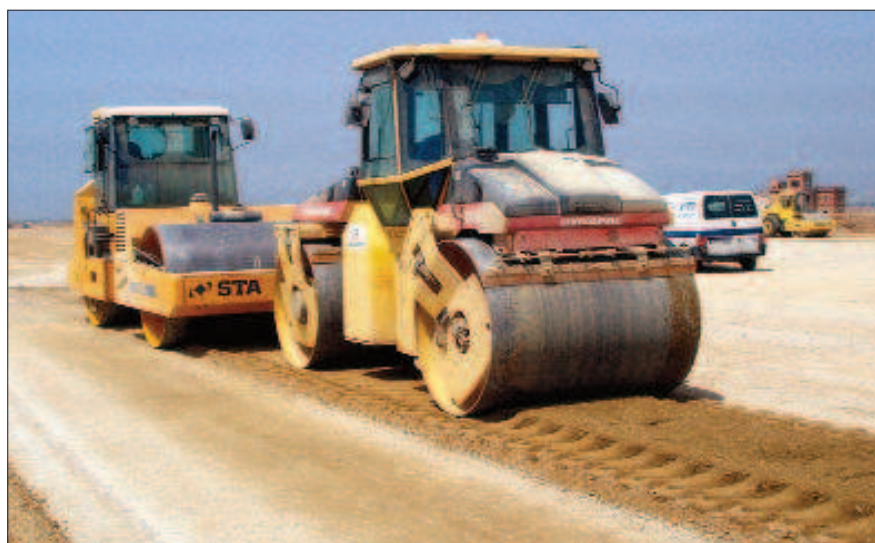
Figura 5.29 Rodillos vibratorios tándem
