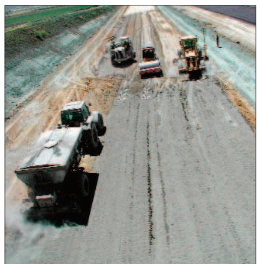
Figura 1.2 Estabilización con cemento
