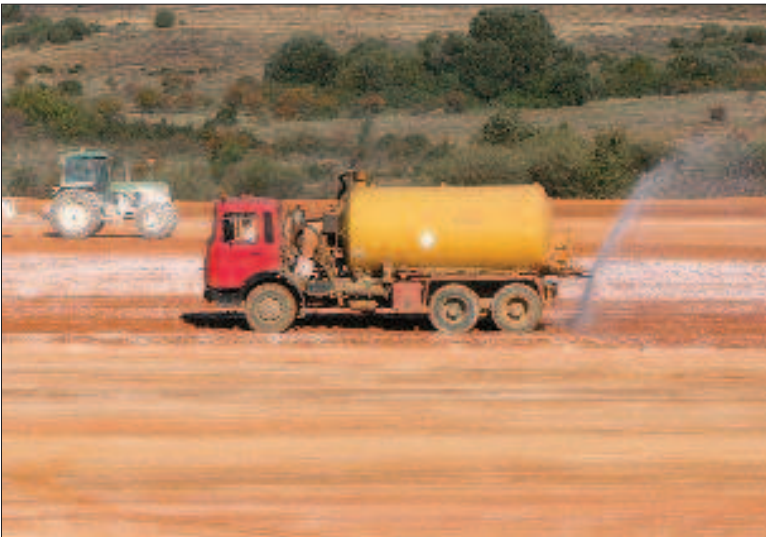
Figura 5.9 Humectación con cisterna
