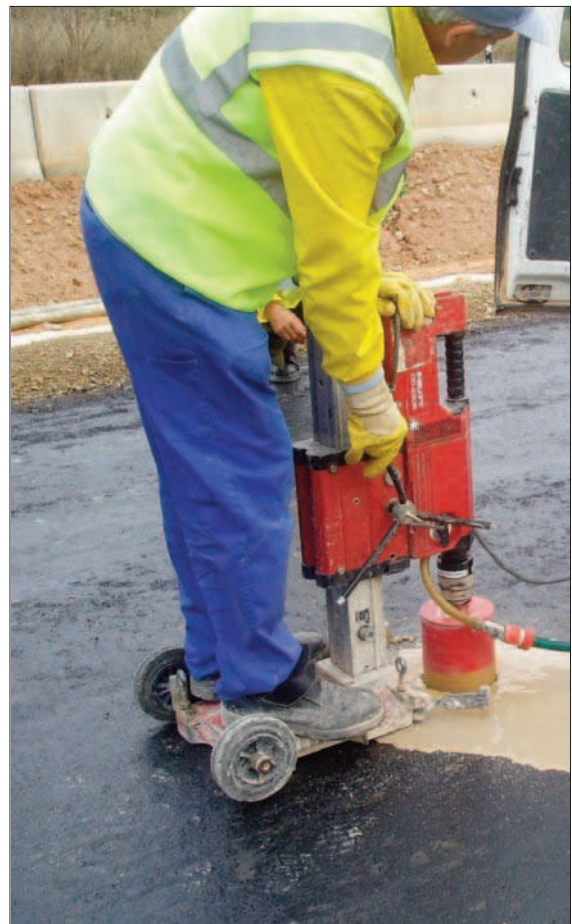
Figura 7.6 Extracción de testigo
