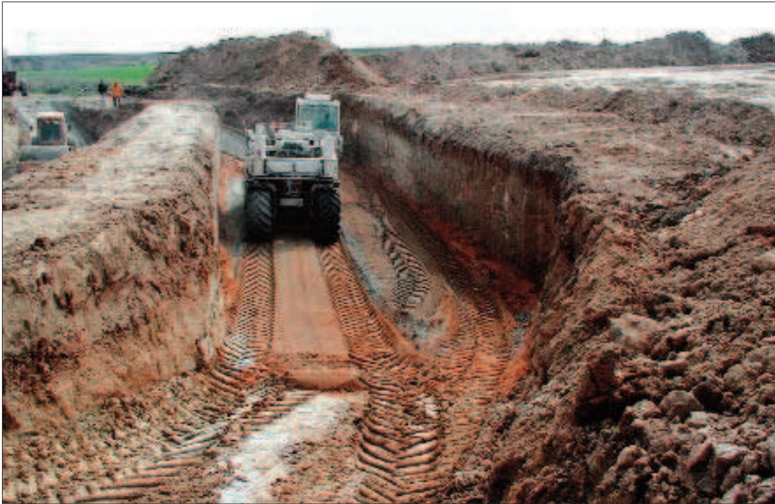
Figura 1. 5 Estabilización de la cimentación de una estructura
