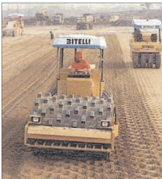
Figura 5.30 Rodillo vibratorio tipo pata de cabra
