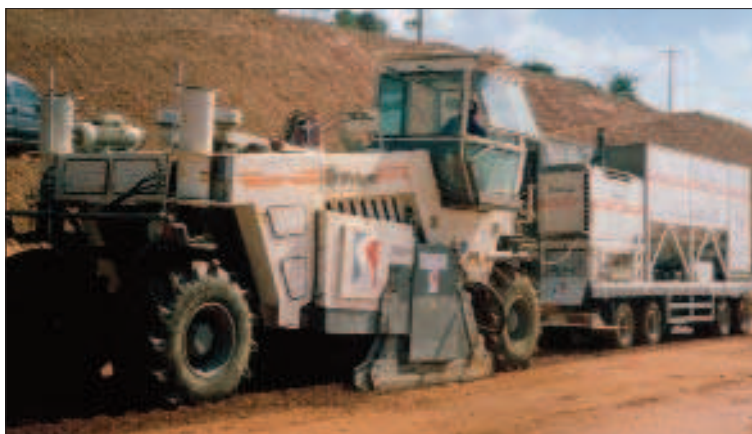
Figura 6.12 Equipo de estabilización
