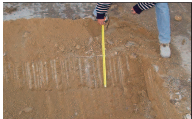
Figura 7.3 Control de espesor de capa estabilizada
