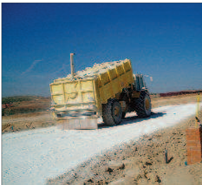
Figura 6.2 Distribución de conglomerante por vía seca
