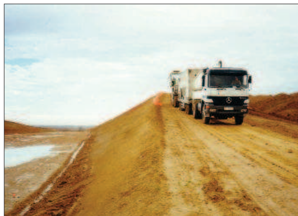
Figura 6.5 Estabilización de un terraplén
