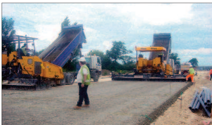
Figura 5.38 Transporte del material estabilizado en camiones basculantes y colocación con extendedoras en paralelo
