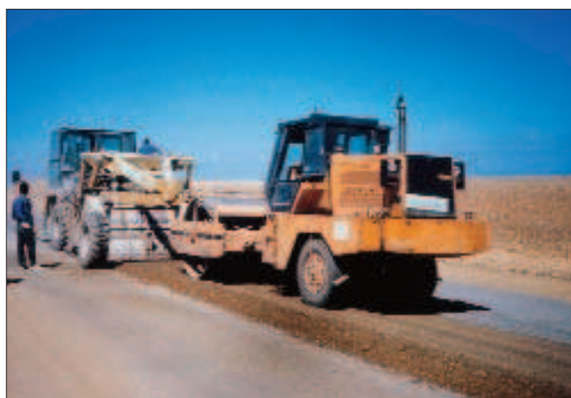
Figura 6.14 Rodillos vibratorios compactando capas estabilizadas
