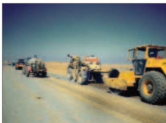
Figura 6.13 Estabilización por calles o bandas cortas con un único equipo, y en bandas largas con dos equipos
