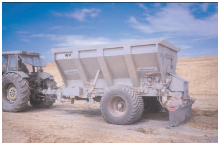
Figura 6.10 Distribución del conglomerante en polvo (vía seca)
