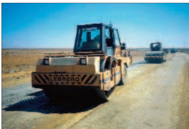
Figura 6.14 Rodillos vibratorios compactando capas estabilizadas
