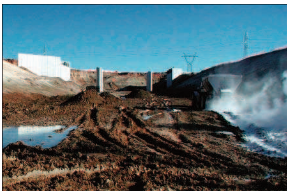
Figura 1.4 Extensión de cal para secado de suelo húmedo
